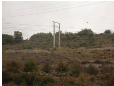
Encosta onde se localiza a obra militar
