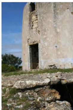
Pormenor da entrada
