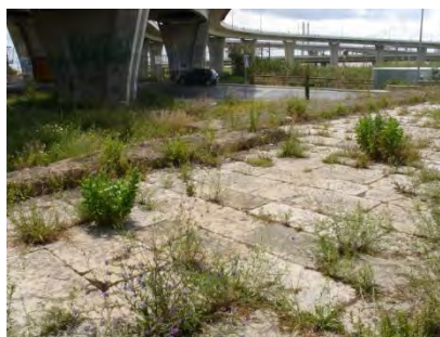
Vista geral do chão lajeado da antiga capela
