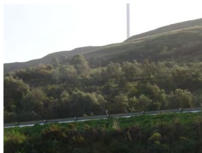
Encosta onde se localiza a obra militar
