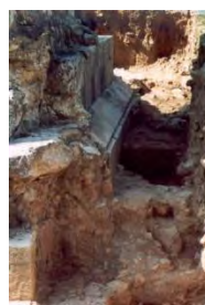
Alçado lateral. Pormenor do paramento
