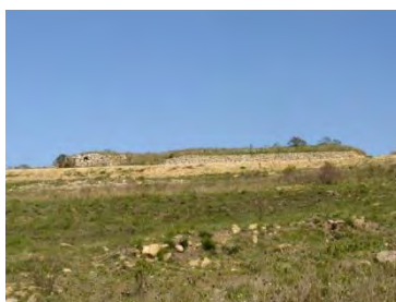
Vista exterior da obra militar
