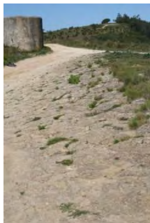
Pormenor da calçada
