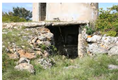
Estrutura inferior de apoio
