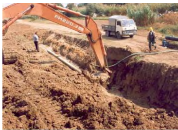
Aspecto dos trabalhos
